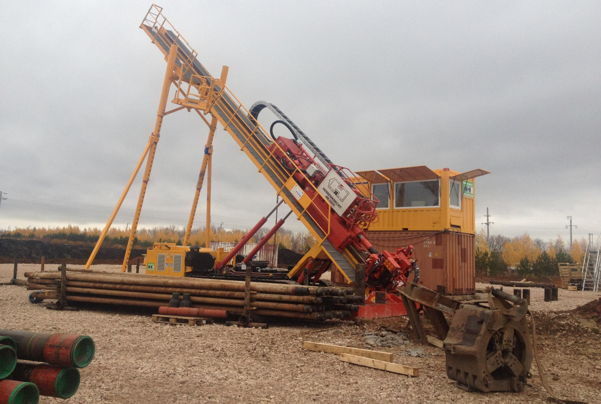
Оборудование: Установка ГНБ на гусеницах
