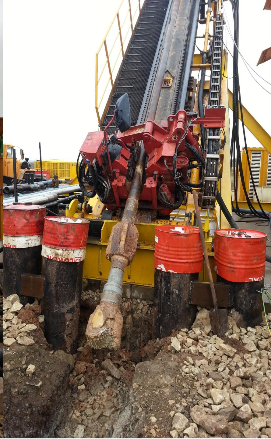
Оборудование: Установка ГНБ на специальной раме
