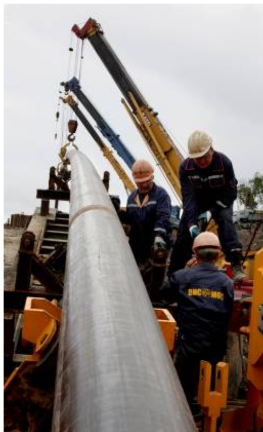
Протягивание плети трубопровода со стороны о. Русский на материк
