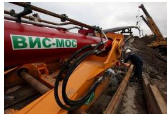
Буровая установка НК-250/90 Herrenknecht
