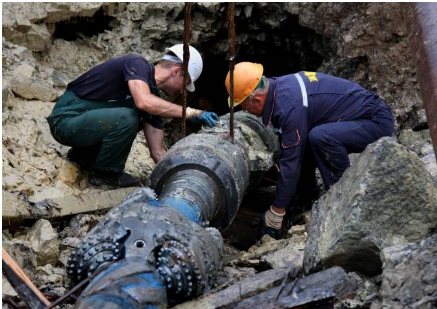
Протягивание плети трубопровода с материковой части г. Владивостока, п-ов Назимова
