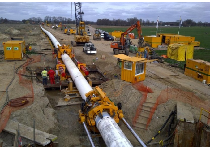
1. Доталкивание для машин DIRECT PIPE + PIPE EXPRESS
