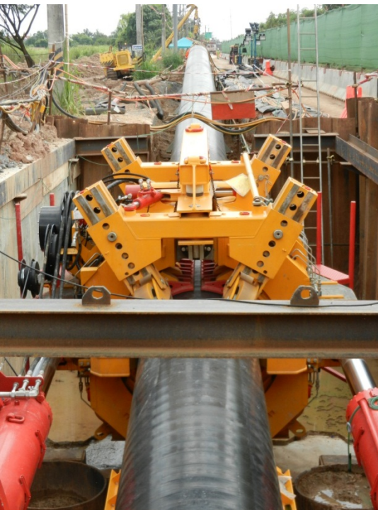
DIRECT PIPE: 6 км трубопровода
