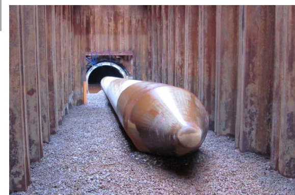
4. Вставка трубопровода в существующий кожух/тоннель
