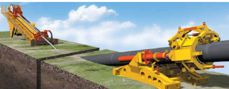
2. Вспомогательное оборудование для ГНБ во время вытягивания трубопровода.
