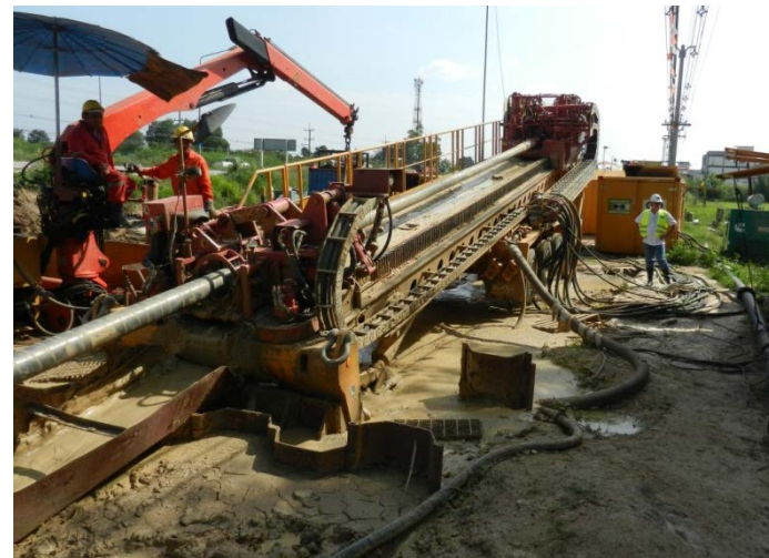
ГНБ: 10 км трубопровода
