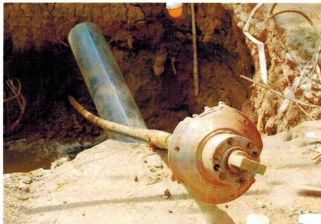
Рис. 2. Наглядная иллюстрация работы по применению технологии ГНБ в условиях стесненности и близости к существующим коммуникациям
