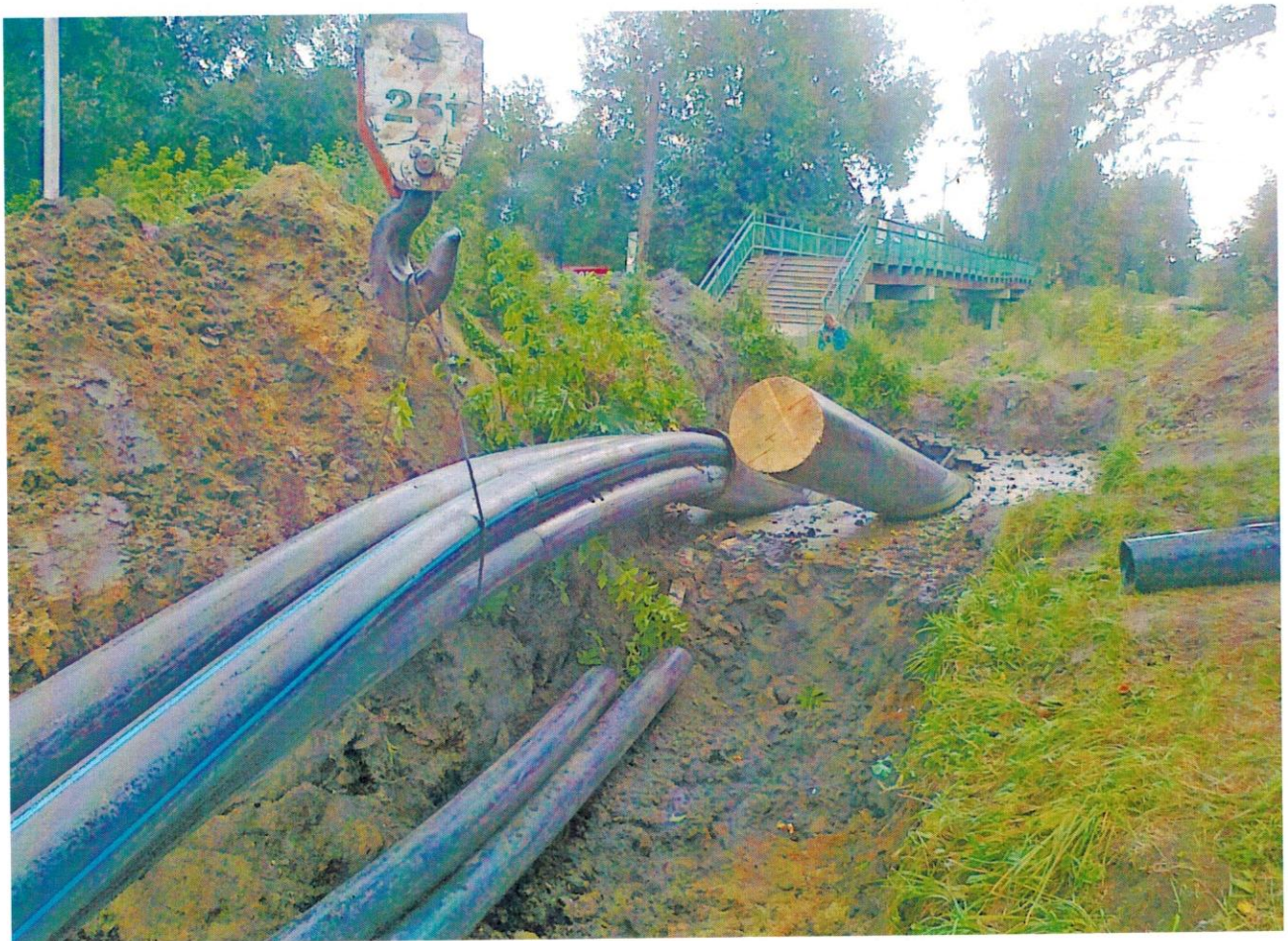
Рис. 4. Финальная стадия успешного завершения устройства закрытого перехода ГНБ с комплексными инженерными параметрами
